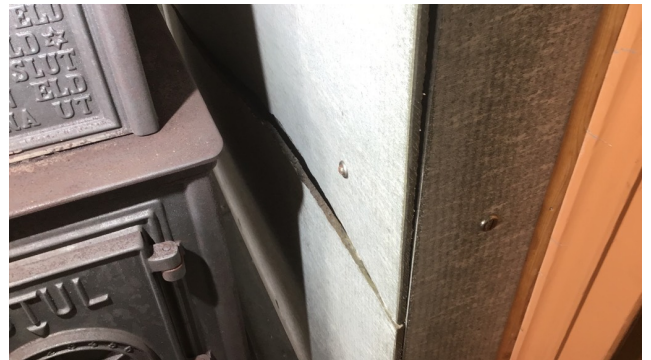
Sprekk/utettheter i brannmur
