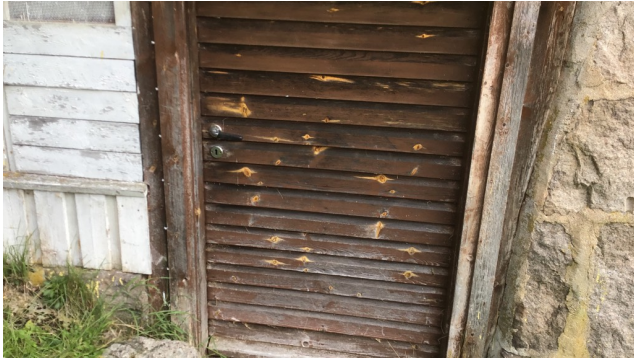
Enkel panelt kjellerdør
