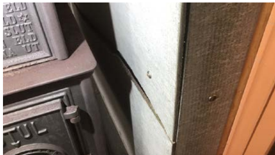
Sprekk/utettheter i brannmur
