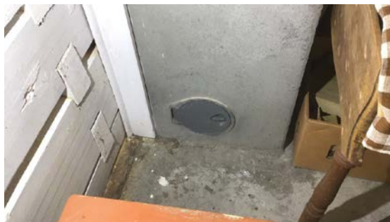
Sprekk/utettheter i brannmur
