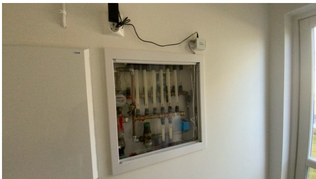
Besiktigelse av røropplegg.
