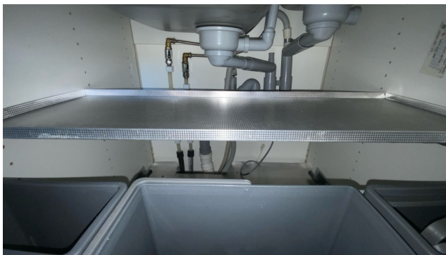
Besiktigelse av røropplegg.
