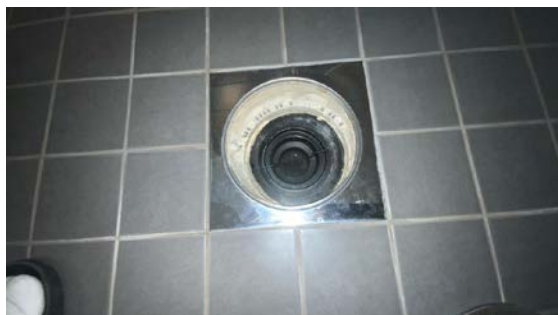
Kontroll av sluk.
