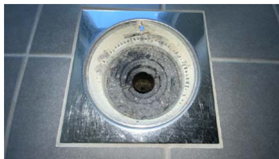
Kontroll av sluk.
