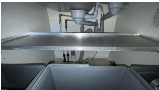
Besiktigelse av røropplegg.
