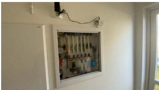
Besiktigelse av røropplegg.
