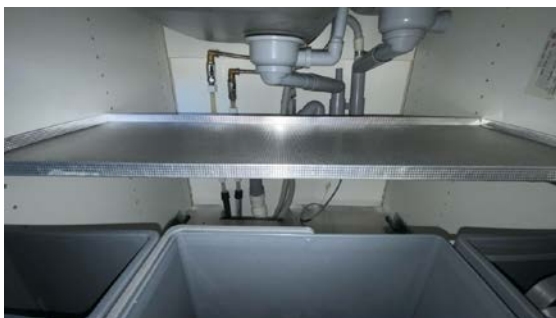
Besiktigelse av røropplegg.
