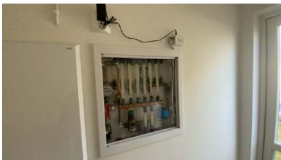
Besiktigelse av røropplegg.
