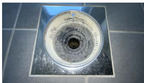
Kontroll av sluk.
