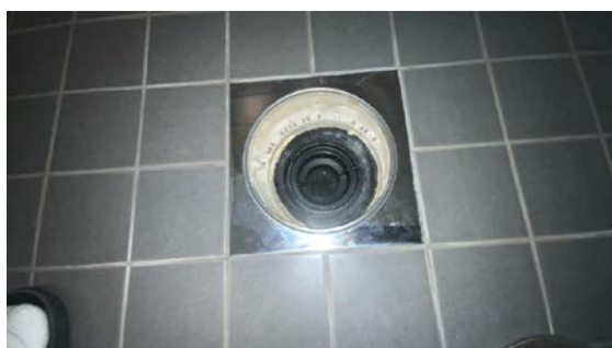
Kontroll av sluk.
