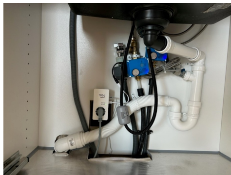
Besiktigelse av røropplegg.
