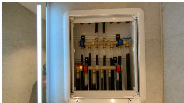
Besiktigelse av røropplegg.
