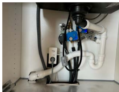
Besiktigelse av røropplegg.
