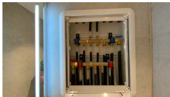
Besiktigelse av røropplegg.
