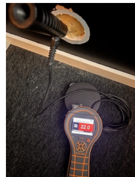
Fuktmåling i påforet grunnmur som ligger mot terreng
