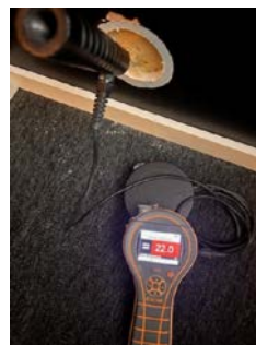
Fuktmåling i påforet grunnmur som ligger mot terreng
