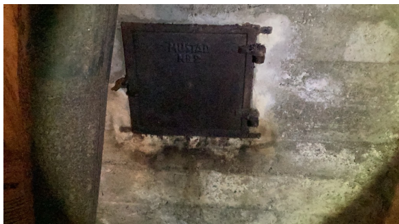
Sotluke i kjeller.
