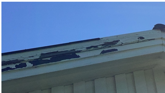
Eksempel på råte på vindskier.
