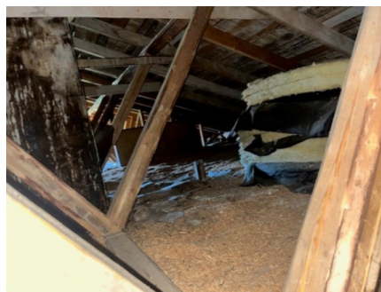
Eksempel på råte på vindskier.
