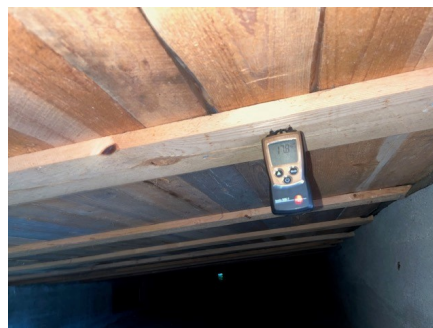
Fukttinnhold på oppunder 20 vektprosent.
