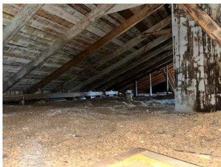
Eksempel på råte på vindskier.
