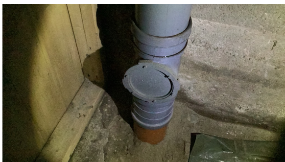
Stakepunkt i kjeller.
