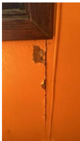
Eksempel på slitasje på overflater.
