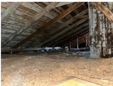
Eksempel på råte på vindskier.
