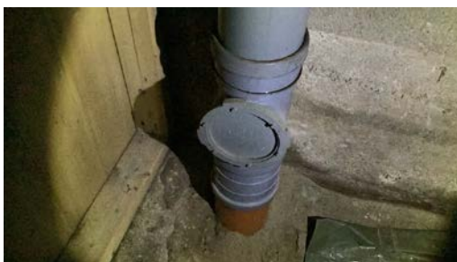
Stakepunkt i kjeller.
