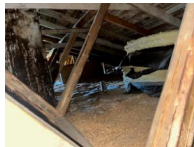
Eksempel på råte på vindskier.
