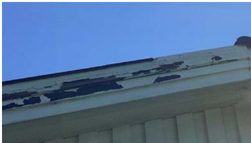
Eksempel på råte på vindskier.
