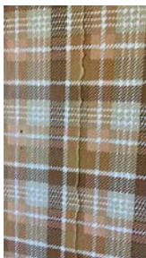
Eksempel på slitasje på overflater.
