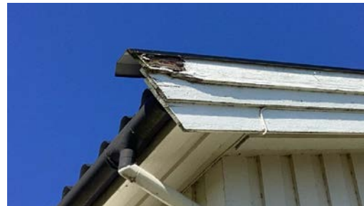
Eksempel på råte på vindskier.
