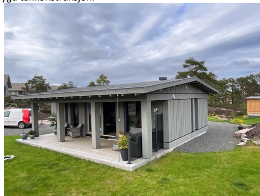
Takkonstruksjon sett fra utsiden.
