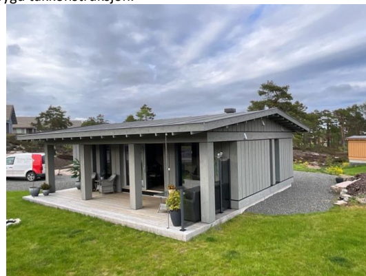
Takkonstruksjon sett fra utsiden.
