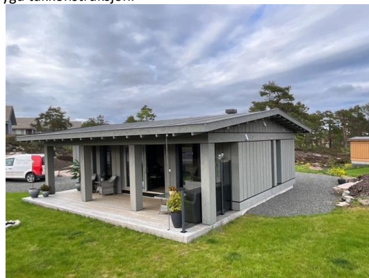
Takkonstruksjon sett fra utsiden.
