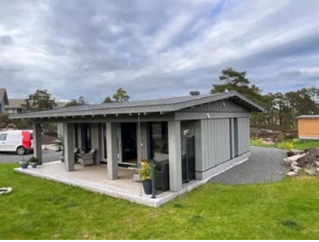
Takkonstruksjon sett fra utsiden.
