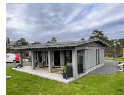
Takkonstruksjon sett fra utsiden.
