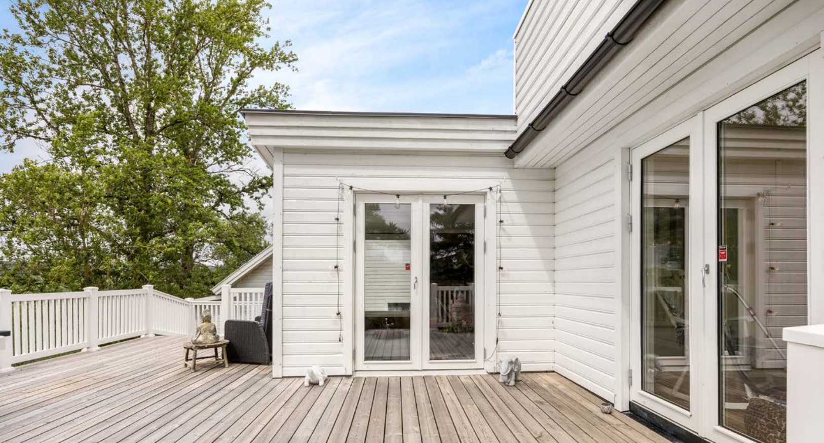
Mot vest ble det i 2022 satt opp en koselig hagestue. Hagestuen er ikke byggemeldt.
