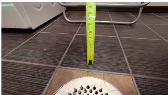
Kontroll av fallforhold.
