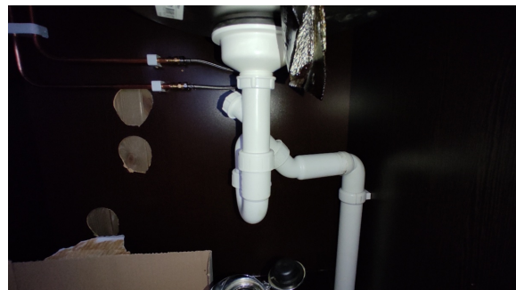
Kontroll av røropplegg.
