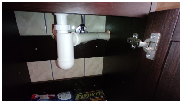
Kontroll av røropplegg.
