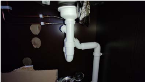
Kontroll av røropplegg.
