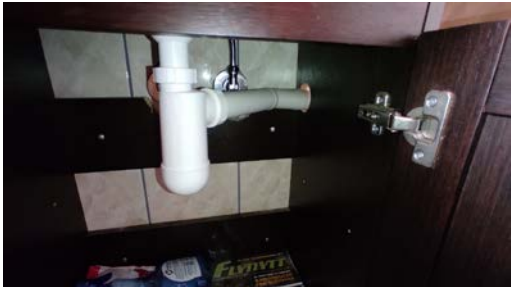
Kontroll av røropplegg.
