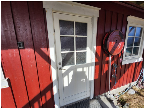
Hovedinngangsdør fra innsiden. Bildet kun for illustrasjon
