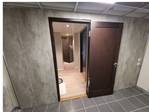
Bad er under arbeid.
