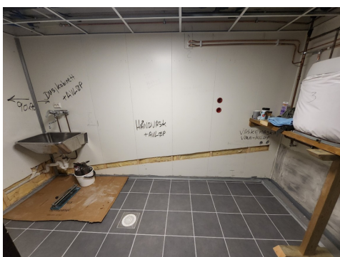
Bad er under arbeid.
