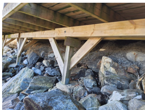
Bildet tatt av konstruksjonen under gangvei/balkong. Bildet kun for illustrasjon.
