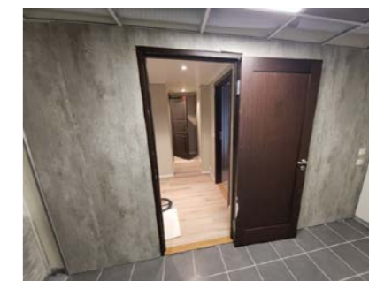
Bad er under arbeid.
