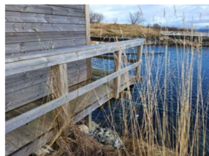
Bildet av gangvei/balkong mot sjøen. Bilde kun for illustrasjon.
