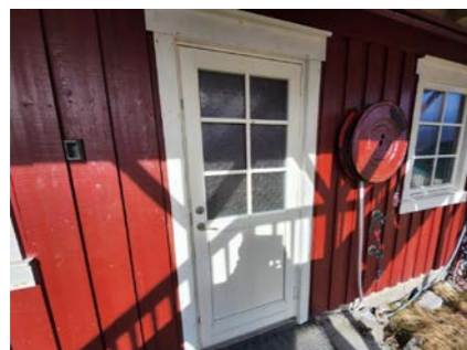
Hovedinngangsdør fra innsiden. Bildet kun for illustrasjon
