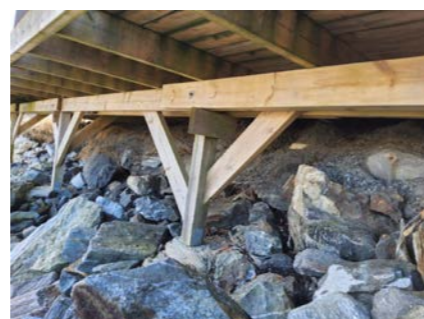
Bildet tatt av konstruksjonen under gangvei/balkong. Bildet kun for illustrasjon.
