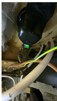
Bilde av sluk på vaskerommet tatt fra kjeller.
