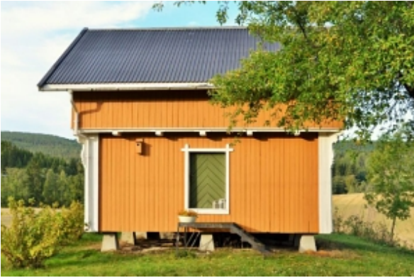
Stabbur Fasade mot tunet.
