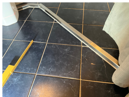
Flere knekte fliser på gulvet.
