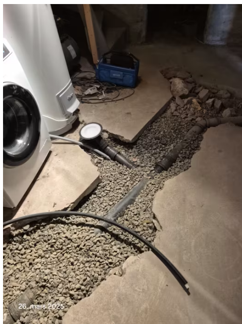
Oppskåret betonggulv i grovkjeller.
