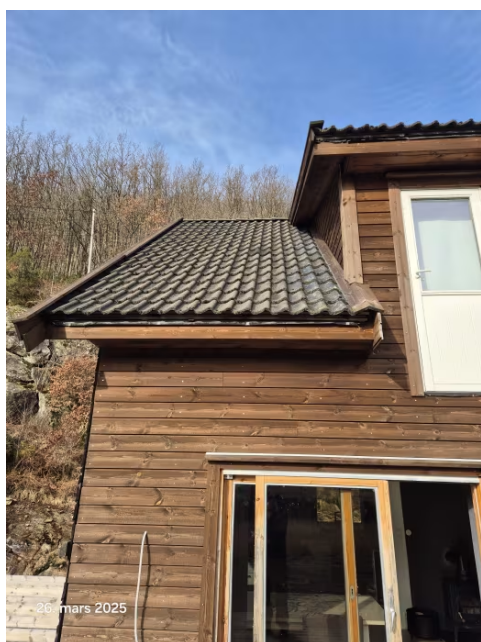
Bilde av tilstand takstein.
