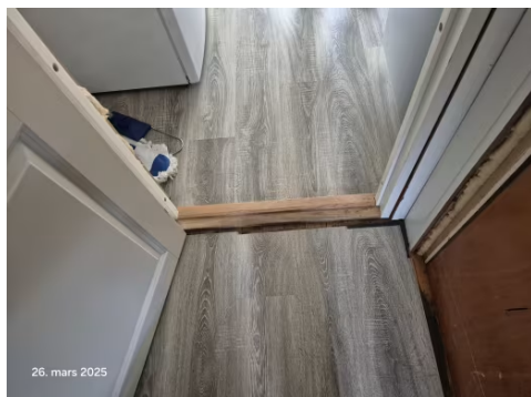
Uferdige arbeider på laminatgulv.
