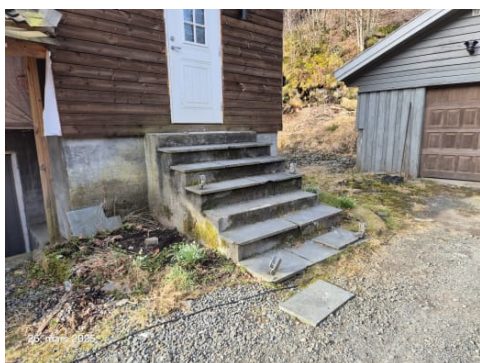
Rekkverk mangler.
