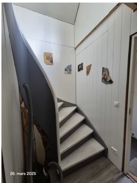
Rekkverk mangler.
