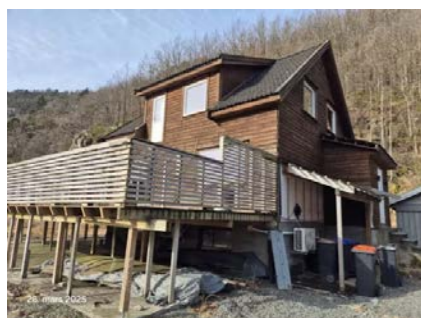
Bildet viser blant annet manglende kledning, vindskier og belistning hoveddør.
