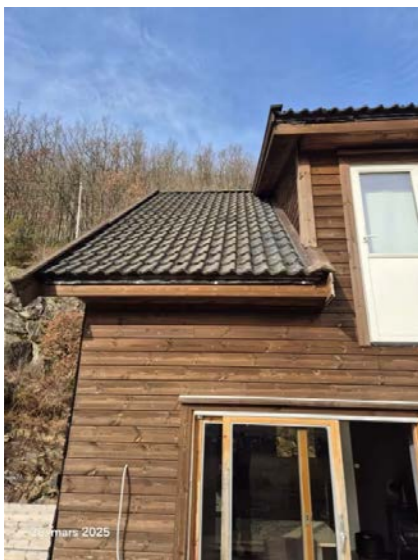
Bilde av tilstand takstein.
