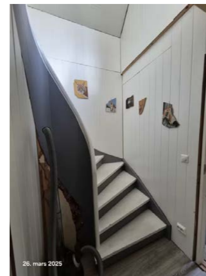
Rekkverk mangler.
