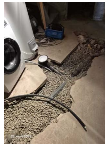
Oppskåret betonggulv i grovkjeller.
