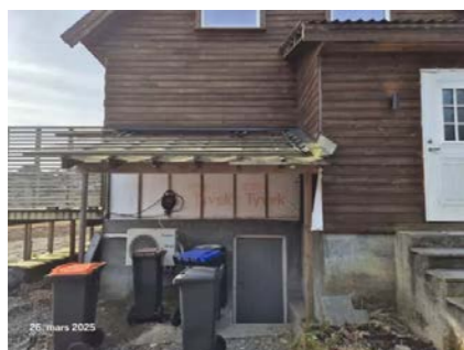
Bildet viser blant annet manglende kledning, vindskier og belistning hoveddør.
