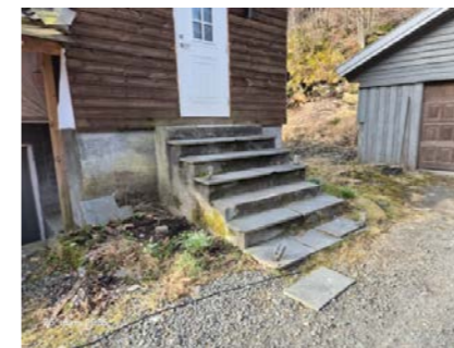
Rekkverk mangler.
