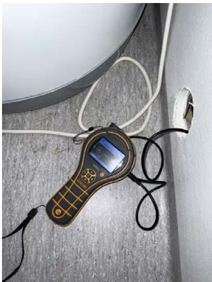
Det er foretatt hulltaking med 73 mm hullbør fra tilstøtende rom (bod). Undersøkelsen viser ingen tegn til skader eller fukt i konstruksjonen.
