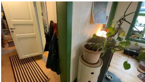
Pipen er tildekket på 3 sider.
