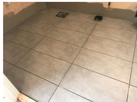
Bilde fra eier under renovering.
