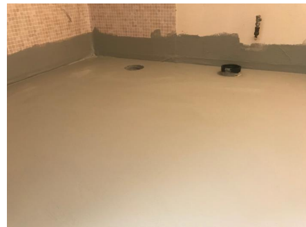
Bilde fra eier under renovering.
