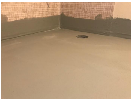
Bilde fra eier under renovering.
