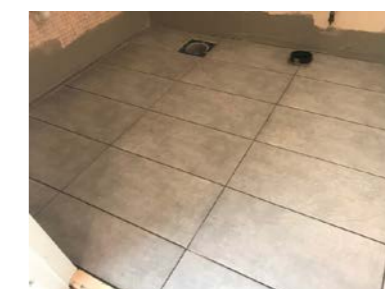
Bilde fra eier under renovering.
