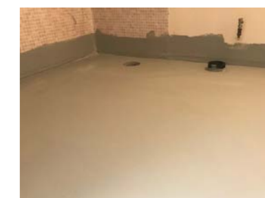
Bilde fra eier under renovering.
