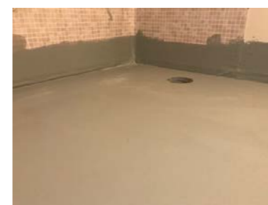
Bilde fra eier under renovering.
