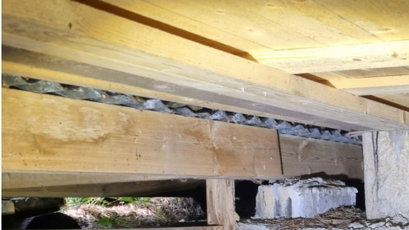
Asbestholdige plater
