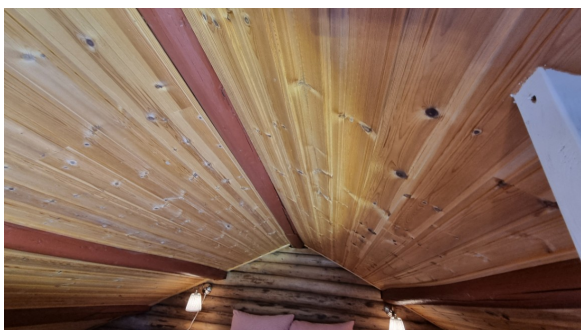
Takkonstruksjonen er gjenbygget.
