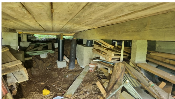
Besiktigelse av fundamenter.
