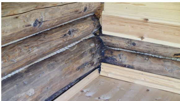
Innvendige fuktmerker/råteskader.
