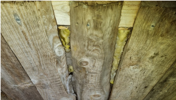
Åpninger/utettheter i stubbegulv.
