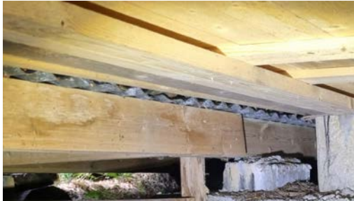
Asbestholdige plater
