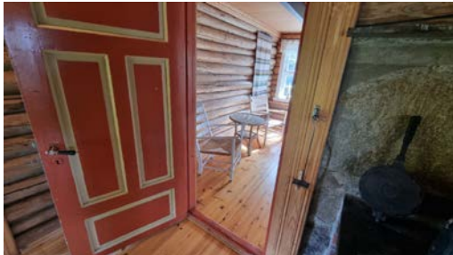
Dør er av eldre dato og har noe bruksmerker.
