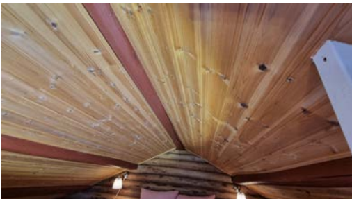
Takkonstruksjonen er gjenbygget.
