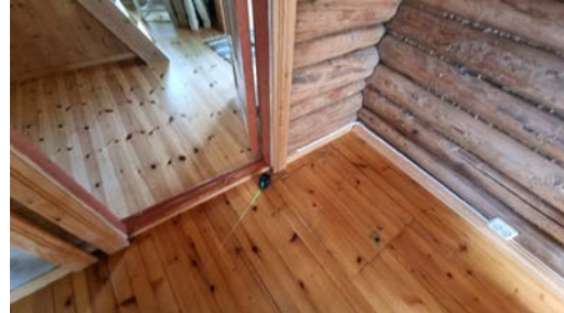
Kontroll av planavvik.
