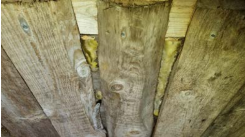
Åpninger/utettheter i stubbegulv.
