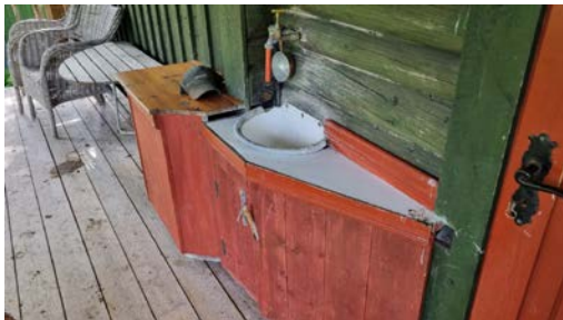
Fritidsboligen har ikke innlagt vann, men det er montert en utekran på yttervegg for uttak av vann.
