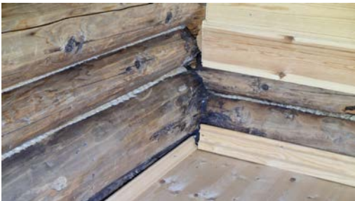
Innvendige fuktmerker/råteskader.
