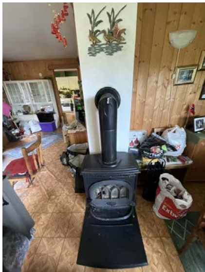
Viser ildsted plassert i stue.
