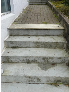
Utvendig trapp på siden av boligen.
