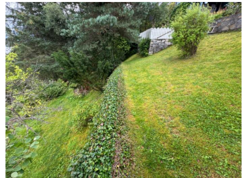
Forstøtningsmur uten rekkverk.
