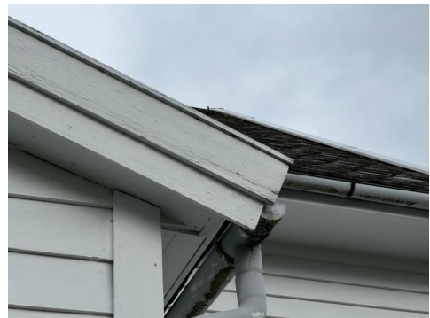
Slitasje i vindskibord.
