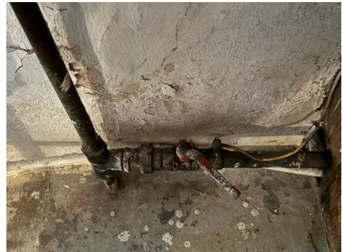
Stoppekran i vaskekjeller i u-etg.
