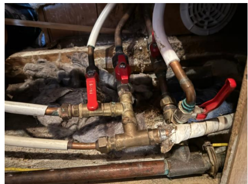
Stoppekraner i gang/trapperom i u-etg.
