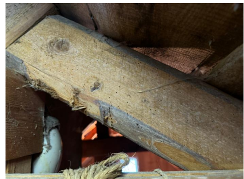
Mithull i taksperr.
