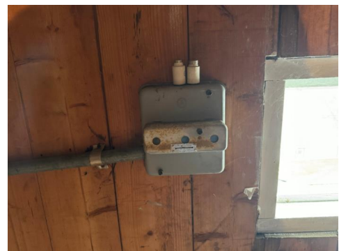
Inntaksikring på koffertloft.
