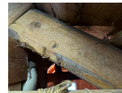
Mithull i taksperr.
