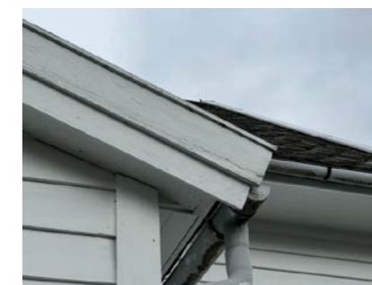
Slitasje i vindskibord.
