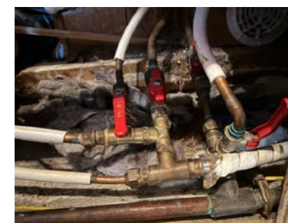
Stoppekraner i gang/trapperom i u-etg.
