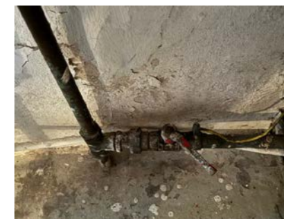
Stoppekran i vaskekjeller i u-etg.
