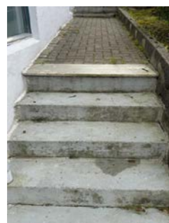
Utvendig trapp på siden av boligen.
