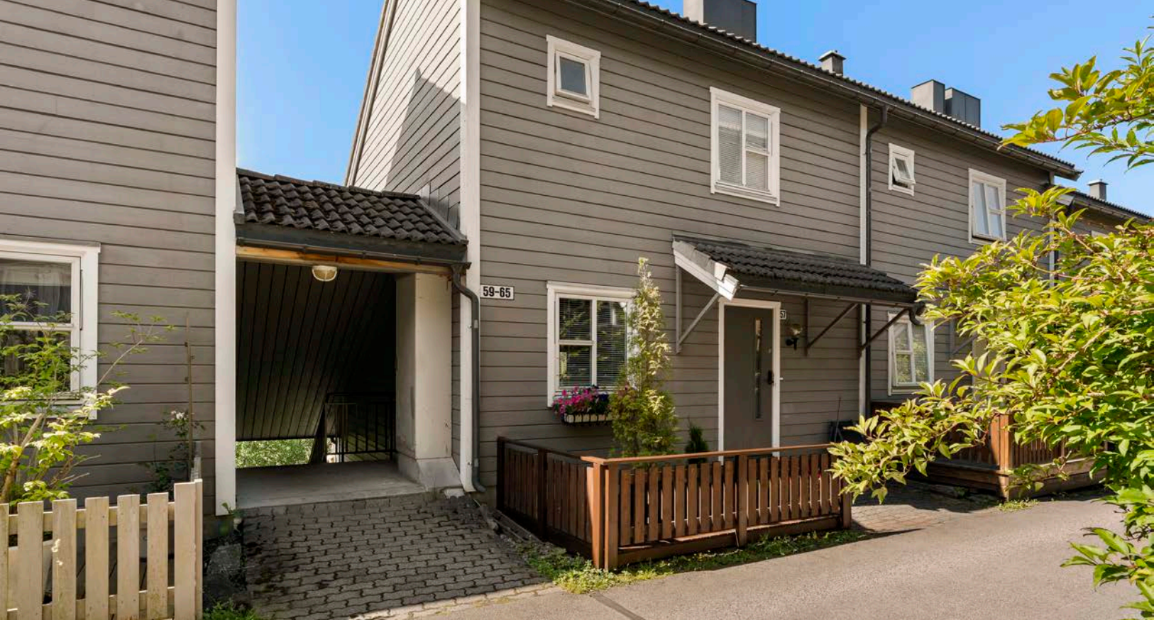
Veldig hyggelig gate med fint inngangsparti i en blindvei med bom. Lite biltrafikk.
