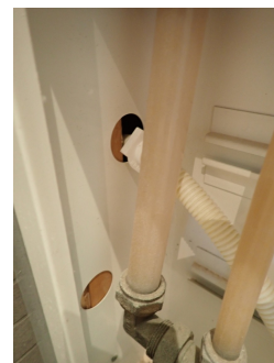
Åpent fra skap og inn i konstruksjonen
