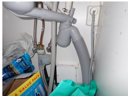
Kjøkken i underetasjen
