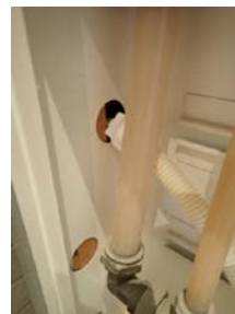
Åpent fra skap og inn i konstruksjonen
