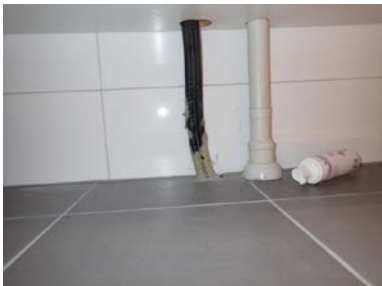
Vannrør under benken
