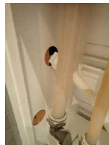
Åpent fra skap og inn i konstruksjonen
