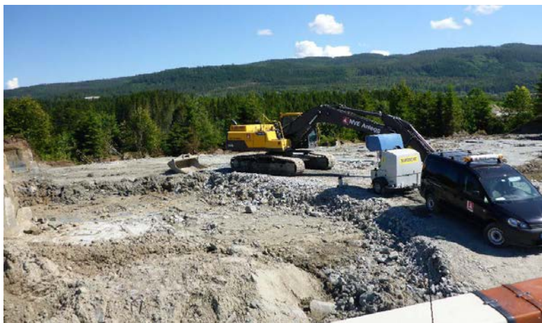
Figur 6.3 Avlastning av skråningstopp i Klæbu i Trøndelag. Foto: Geir B. Hagen, NVE
