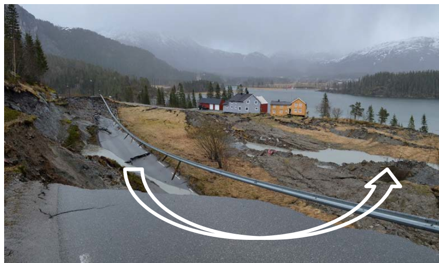
Figur 2.11: Rotasjonsskred i Tosbotn 2016. Foto: Fredrik Høgaas, NGU
