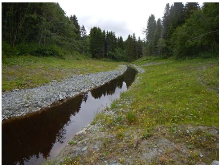
Figur 6.4 Motfylling og hevet bekkebunn i Klæbu i Trøndelag. Foto: Geir B. Hagen, NVE
