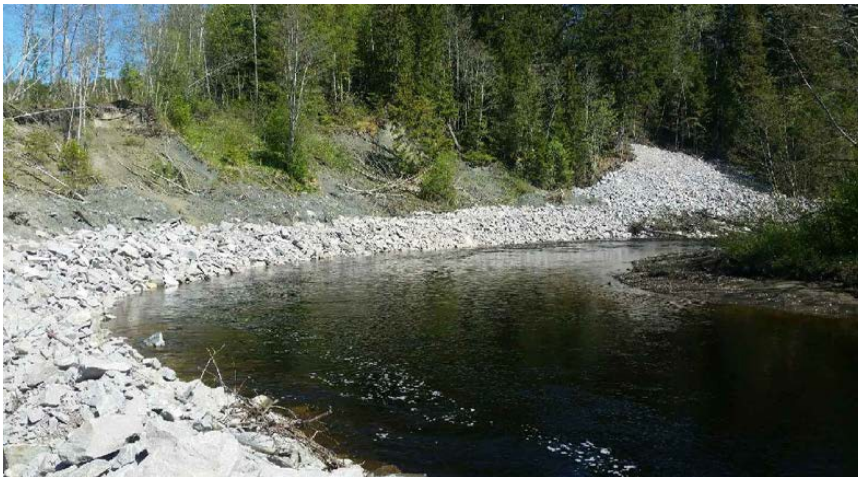
Figur 6.1 Erosjonssikring i Jørstadelva i Snåsa kommune i Trøndelag. Foto: Ida Eggen, NVE
