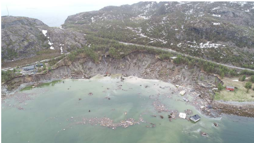
Figur 2.13 Juni 2020 gikk et stort kvikkleireskred i strandsonen ved Kråknes, Alta kommune. Foto: Anders Bjordal, NVE
