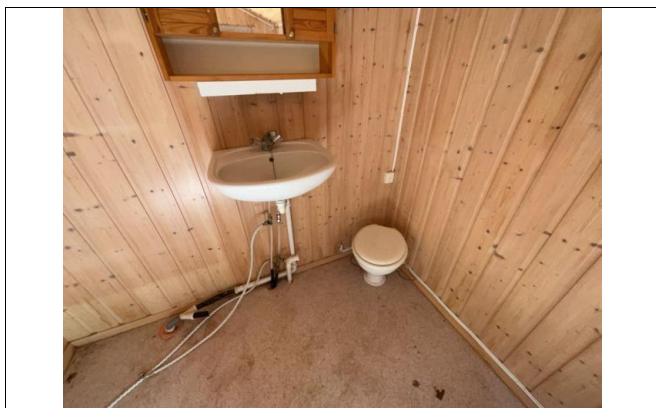
Det er montert en håndvask og en toalett løsning i bod på hovedhytte. Funksjoner eller andre forhold rundt dette er ikke testet eller undersøkt på befaringdagen.
