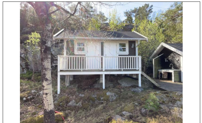
Bod nr 1 på eiendommen.
