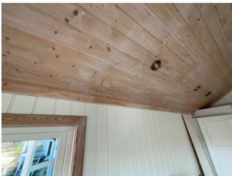
Del av vegg - tak.
