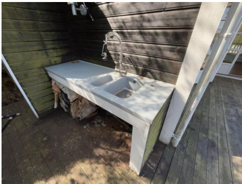
Etablert utekjøkken med varmt og kaldt vann.
