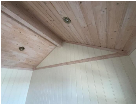
Del av vegg - tak.
