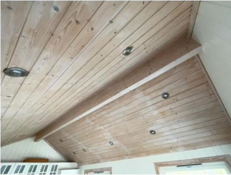
Tak sett fra innsiden.
