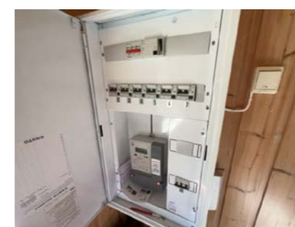
Sikringskap. Dette står ned i hovedhytten.
