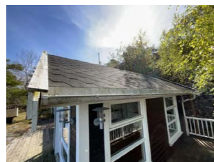
Del av taktekking.
