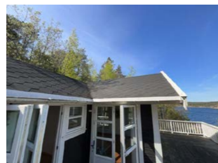
Del av taktekking.
