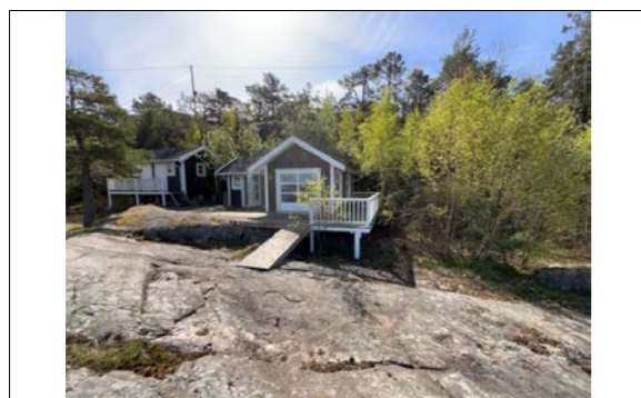
Anneks og bod nr1 på eiendommen.
