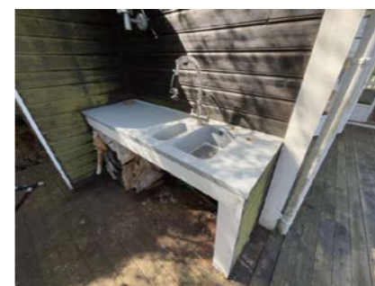
Etablert utekjøkken med varmt og kaldt vann.
