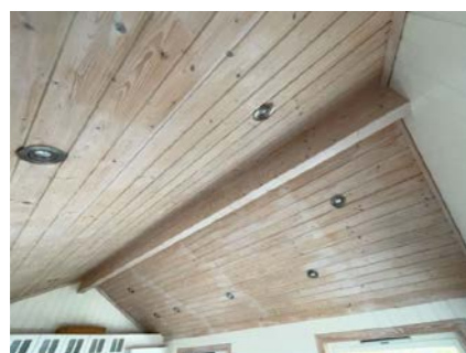
Tak sett fra innsiden.
