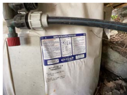
Spekk på varmtvannstank.
