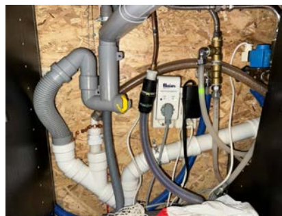
Røropplegg i kjøkkenbenk med Waterguard
