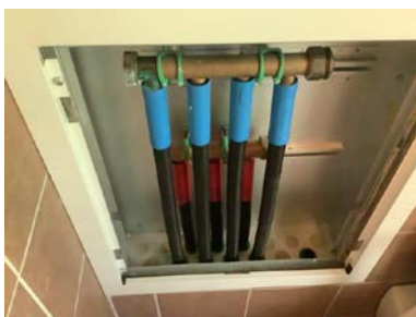
Rør i rør til bad i 2. etasje.
