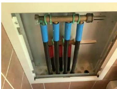
Rør i rør til bad i 2. etasje.
