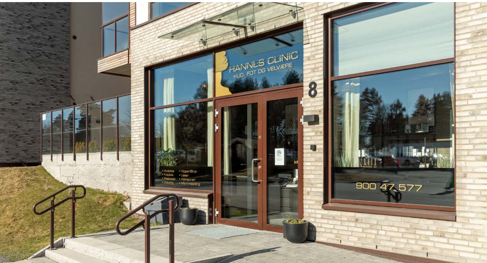
Næringslokalet ligger like over gaten for Aurskog senter.
