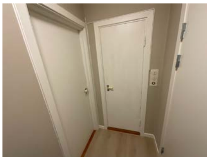
Bad og soveromsdør
