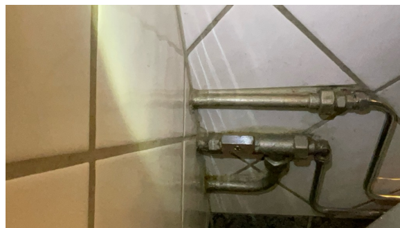
Vrider på hovedstoppekran mangler.
