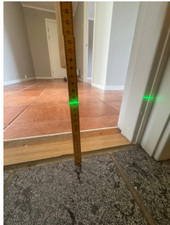
Dårlig fall på gulv og lav høyde på terskel.
