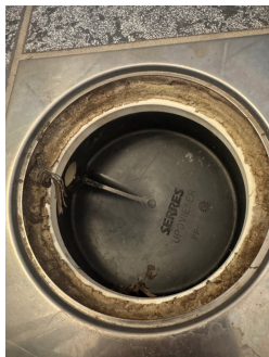
Dårlig fall på gulv og lav høyde på terskel.
