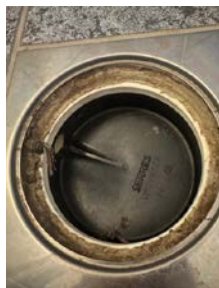
Dårlig fall på gulv og lav høyde på terskel.
