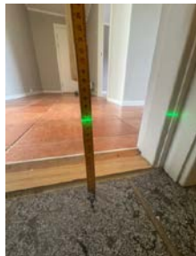
Dårlig fall på gulv og lav høyde på terskel.
