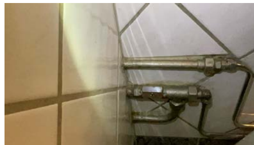
Vrider på hovedstoppekran mangler.
