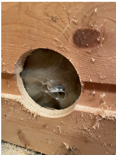
Dampsperre i vegg
