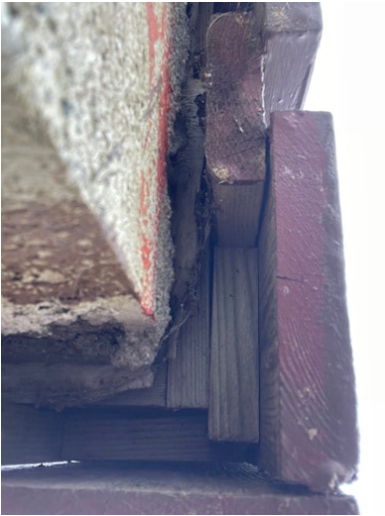
Kledning uten lufting
