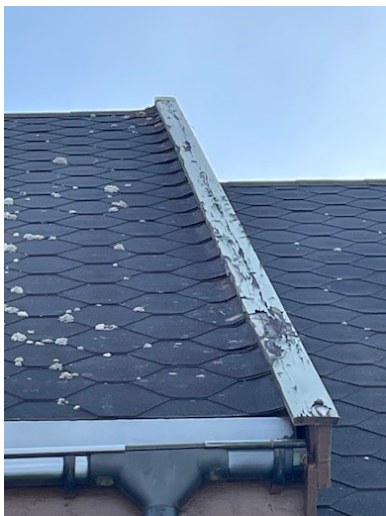
Fuktskade vannbord
